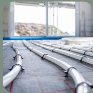
PASSIVE KÜHLUNG (FREE-COOLING) ÜBER BODENHEIZUNG
